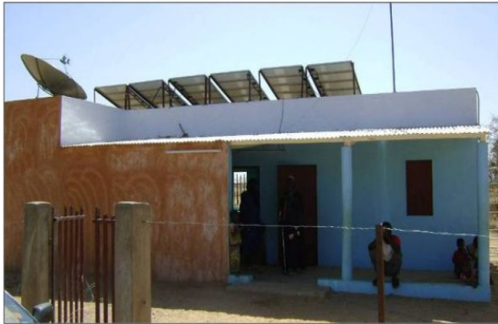
Figure 8: Projet d'électrification Rurale dans le Brakna, Mauritanie – Multiservice Platform powered by rooftop solar PV system
